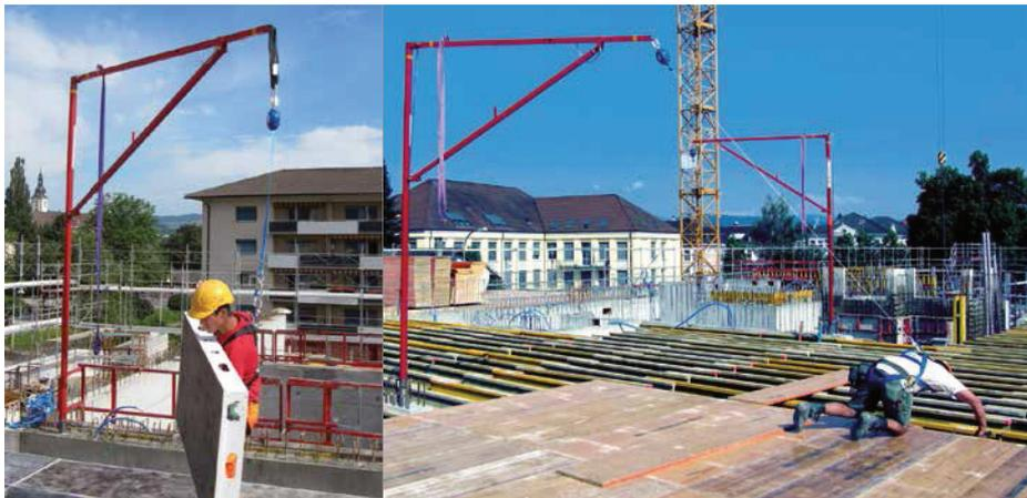
Système de protection individuelle permettant de mener en toute sécurité les opérations de mise en place de panneaux, de garde-corps, de filets de type V et de cloisons de coffrage, et en règle générale tous les cas de figure en relation avec les travaux de montage du coffrage comportant un risque de chute dans le vide.
