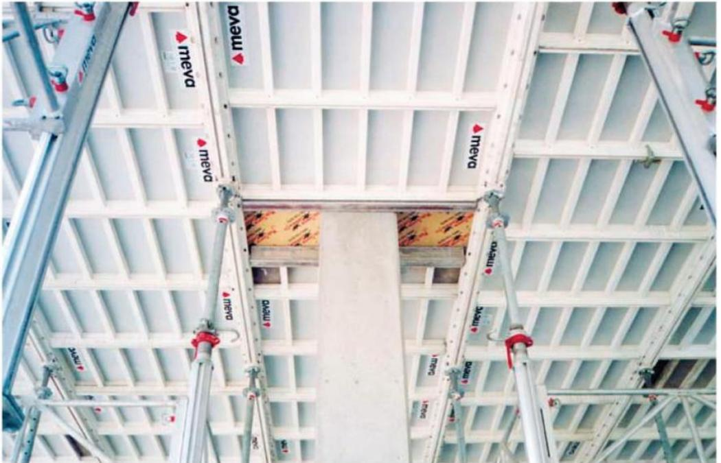
Le positionnement des poutrelles et des panneaux en continu permet une adaptation facile à la géométrie de la construction
