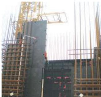
La manipulation manuelle et la facilité de montage des panneaux permettent de réaliser le coffrage dans toutes les situations du chantier
