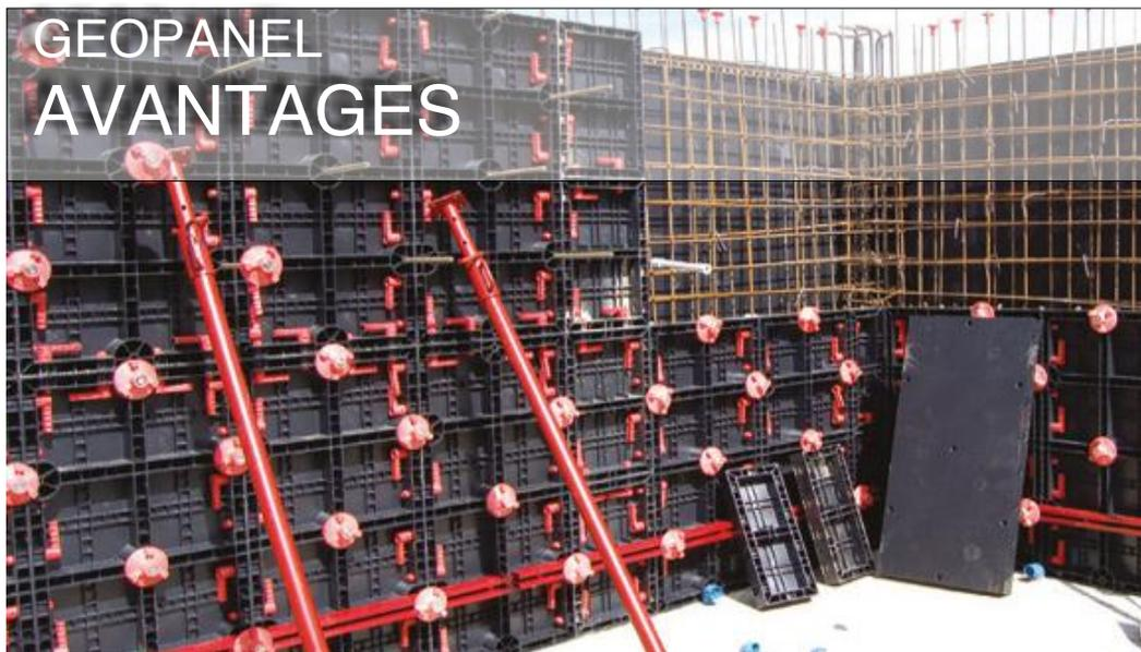
Le seul système léger, réutilisable et modulaire pour la réalisation de maçonnerie en béton
